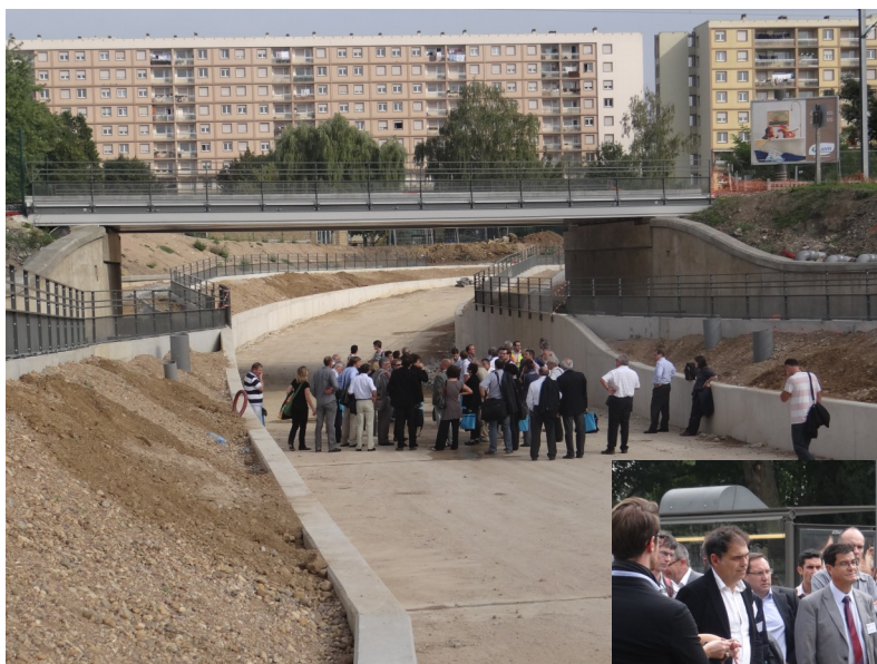
Visite du passage dénivelé de La Patrotte
