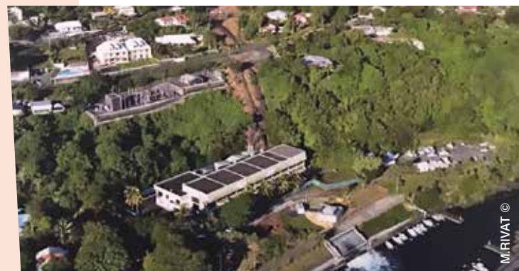
Centrale hydroélectrique EDF de Sainte-Rose 20 août 2019
