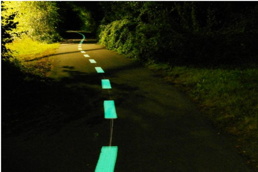
Conçue par la société girondine OliKrom, LuminoKrom® est la première peinture routière photoluminescente. Le procédé : ce marquage capte et stocke la lumière du soleil ou la lumière artificielle, et s'illumine dans l'obscurité. LuminoKrom® est une innovation de rupture : la peinture s'éclaire sans électricité et sans émission de CO2, créant la nuit un balisage lumineux écologique qui encourage les mobilités douces et prépare la ville de demain.
