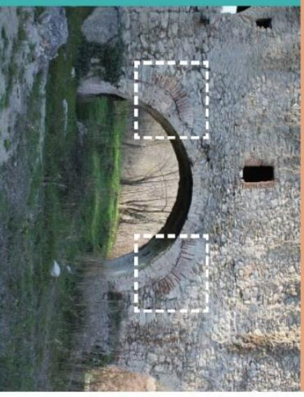
Au III<sup>e</sup> siècle après J.-C., un ouvrage bien plus modeste enjamrait déjà le lit de l'Agly. Il ne reste de ce simple pont romain que les vestiges d'un arc construit en brique, en rive droite de l'Agly.
