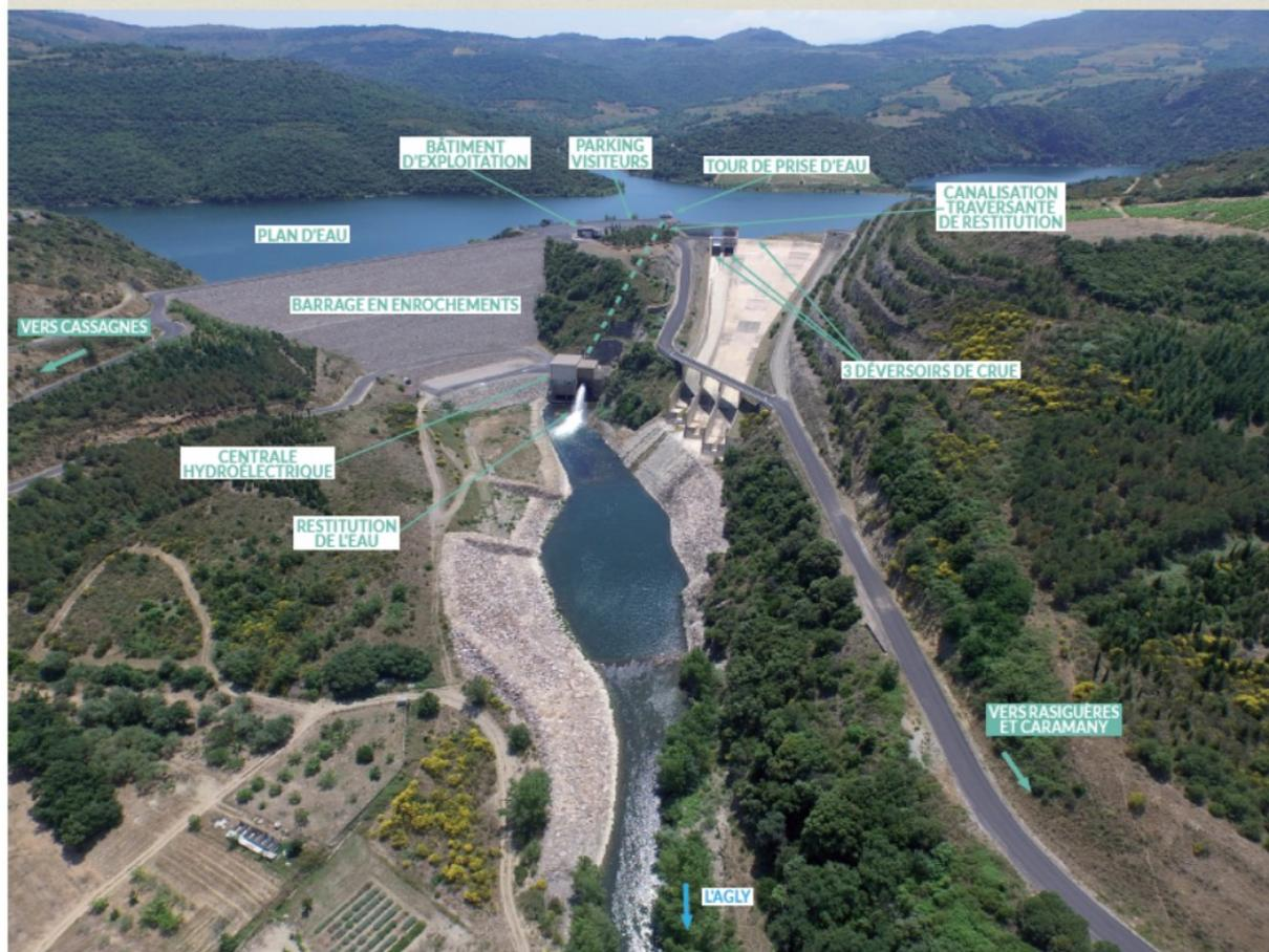
Le barrage stocke de l'eau en automne, en hiver et au printemps, lorsque les débits du fleuve sont suffisants pour ensuite les restituer en été lorsque les besoins en aval sont importants.
