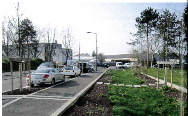
Détail d'un jardin de pluie et d'une noue paysagère pour la gestion des eaux pluviales de voirie sur la ZAC de l'Hôtel de Ville à Vaulx en Velin.
