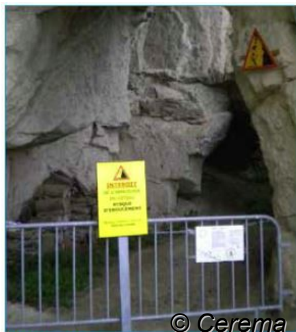
Illustration 3.9 : Zone sous-cavée interdite d'accès (affiche d'information à gauche et arrêté municipal à droite), Montsoreau (49) [crédit Cerema Centre-Est, 2013]
