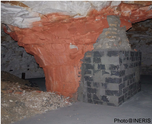
Figure 6 : Reprise d'un pilier par maçonnerie
