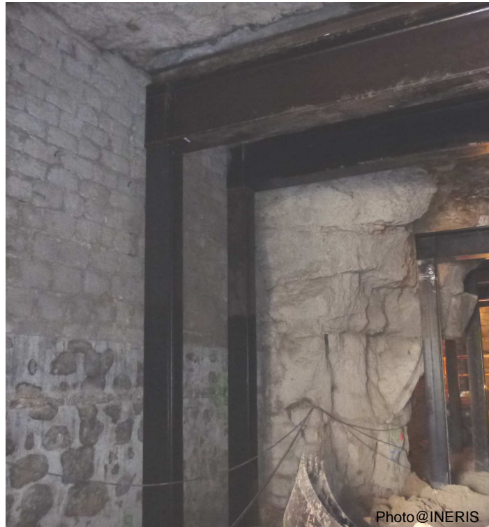
Figure 9 : Soutènement par portique
