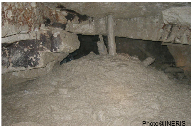
Figures 10 : Comblement par déversement gravitaire
