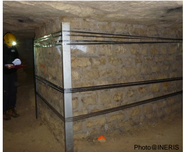
Figure 7 : Cerclage-ceinturage d'un pilier
