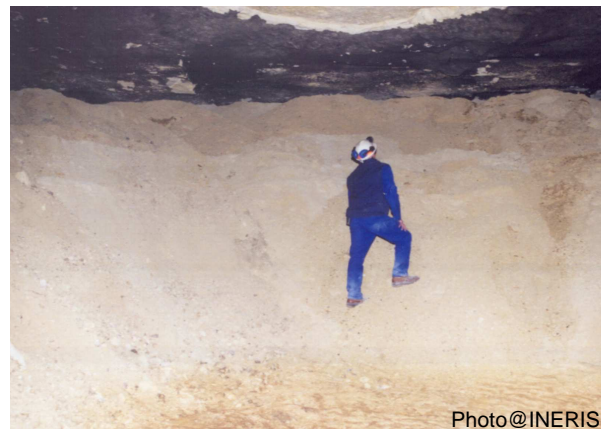
Figures 10 : Comblement par déversement gravitaire
