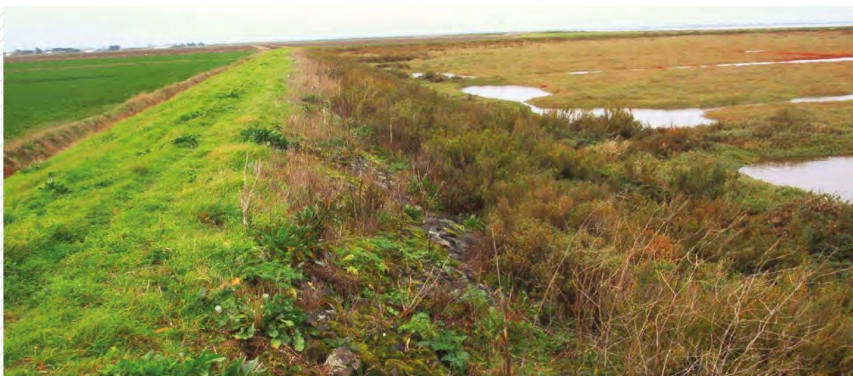
Photo 15 : Digue en terre de polder, renforcée de blocs non appareillés, Port du Bec à Beauvoir-sur-Mer (85)
