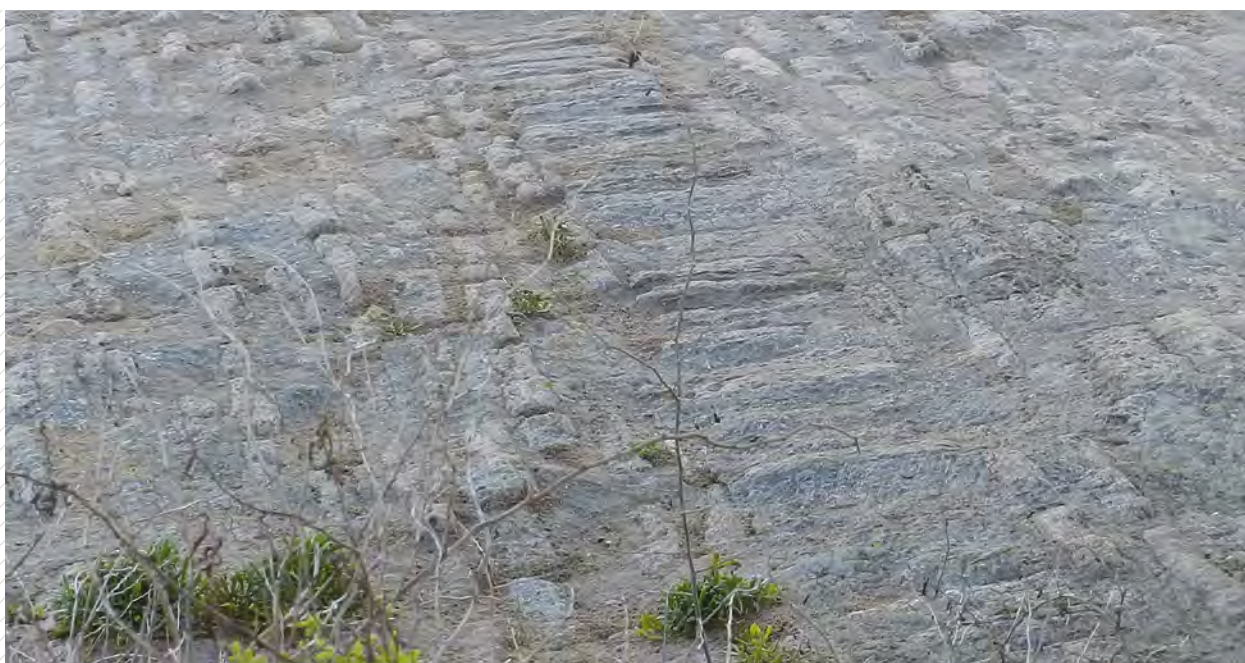
Photos 7 et 8 : Saint-Clément-des-Baleines, vue générale et agrandissement de l'appareillage en pied de digue
