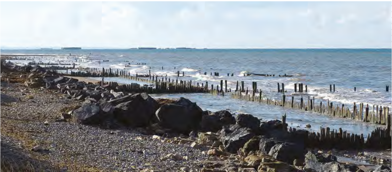
Photo 20 : Site de Ver-sur-Mer/Asnelles (14) : ensemble composite de protections, en bois et en enrochement, perpendiculaire et parallèle au rivage, antérieur au classement. La côte a continué à reculer. Au fond, site d'Arromanches, les pontons.
