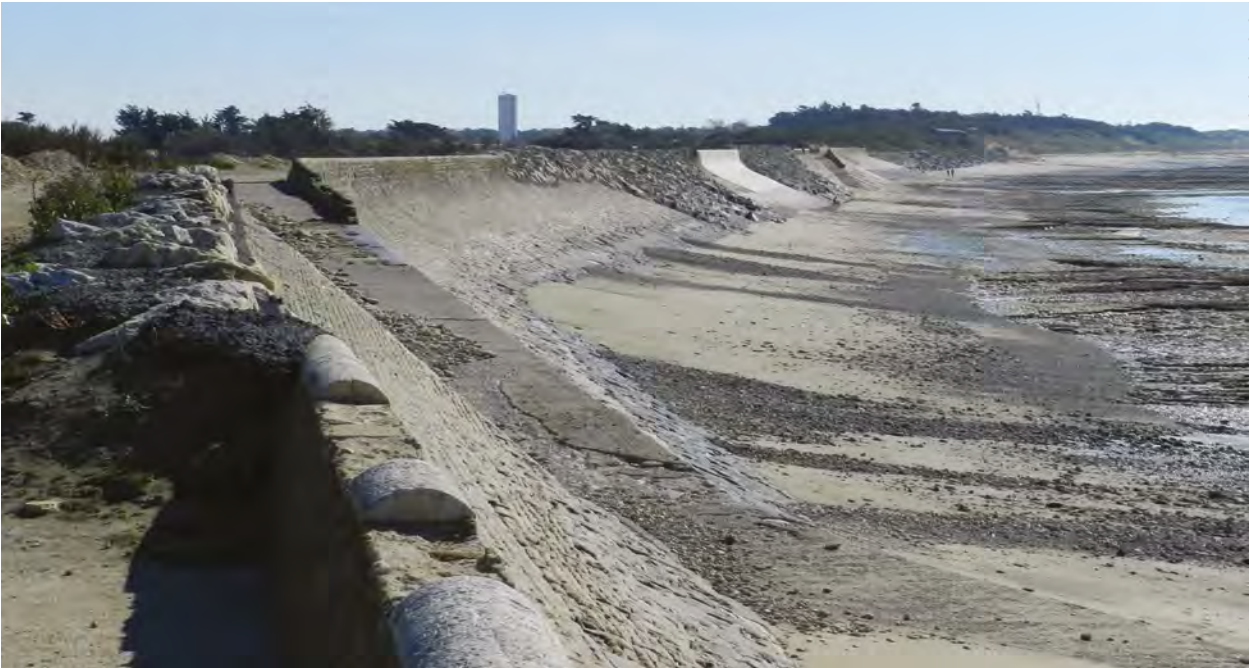
Photo 9 : Les travaux de réparation très hétérogènes entrepris sur la digue des Doreaux à Saint-Clément-des-Baleines (17), avec entre autres une dalle bétonnée, un essai en pierre sciée (section claire en bout de digue), du rejointoiement grossier et un état global médiocre
