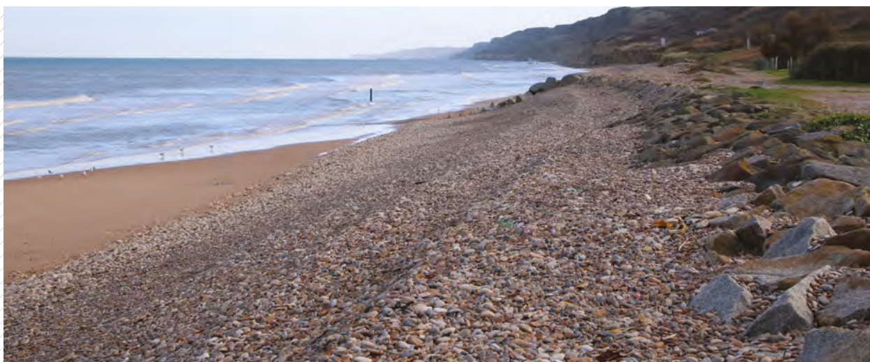
Photos 11 et 12 : Site d'Omaha Beach (14) : la digue a été prolongée, et l'abaissement de la plage a conduit à protéger son pied par un enrochement, qui plus est de couleur noire. Plus loin, le cordon de galets.
