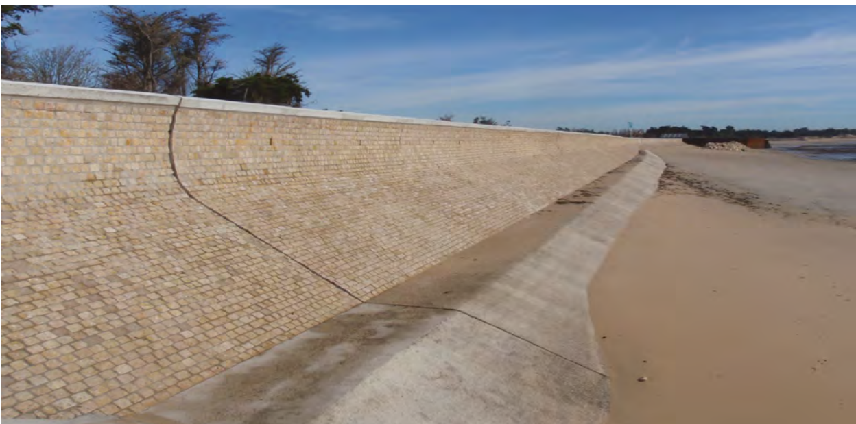
Photo 13 : La digue du Boutillon, île de Ré (17). Une solution esthétiquement satisfaisante mais onéreuse
